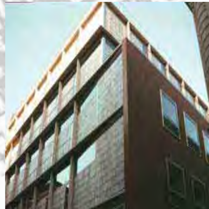
EDIFICIO ADMINISTRATIVO COMUNIDAD DE MADRID. C/ CARRETAS, 4 FCC, S.A. ARQº.: FRECHILLA & LOPEZ PELAEZ
