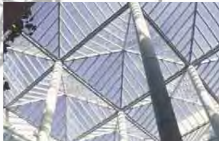
EDIFICIO DE OFICINAS - C/ JOSEFA VALCARCEL - MADRID. ARQº.: D. FEDERICO ECHEVARRIA
