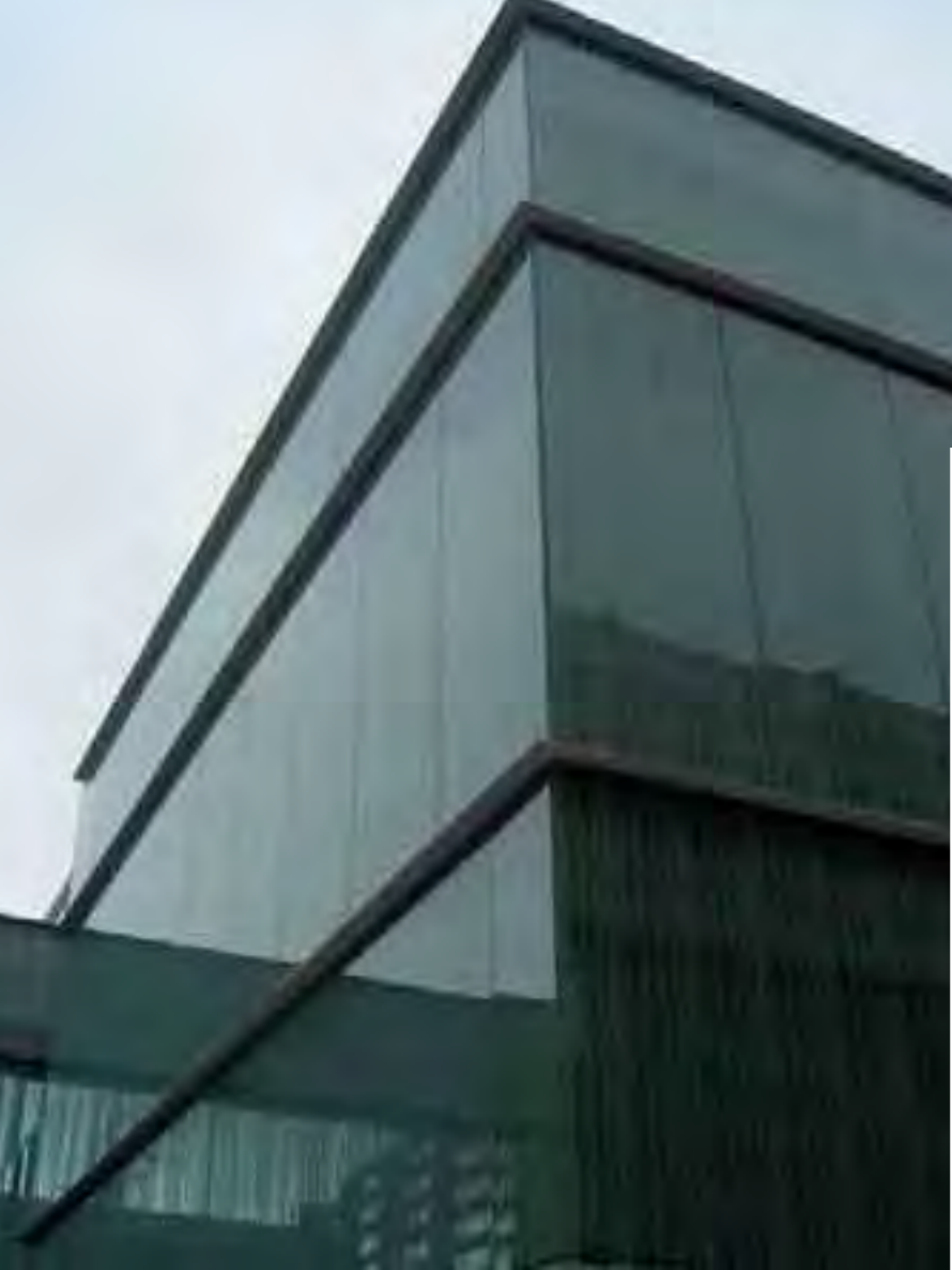
CENTRO TECNOLÓGICO DEL CALZADO. ARNEDO. LA RIOJA Vidrios laminados templados y serigrafiados con diseño tipo código de barras, colocados a hueso siendo anclados mecánicamente en los lados superior e inferior.
