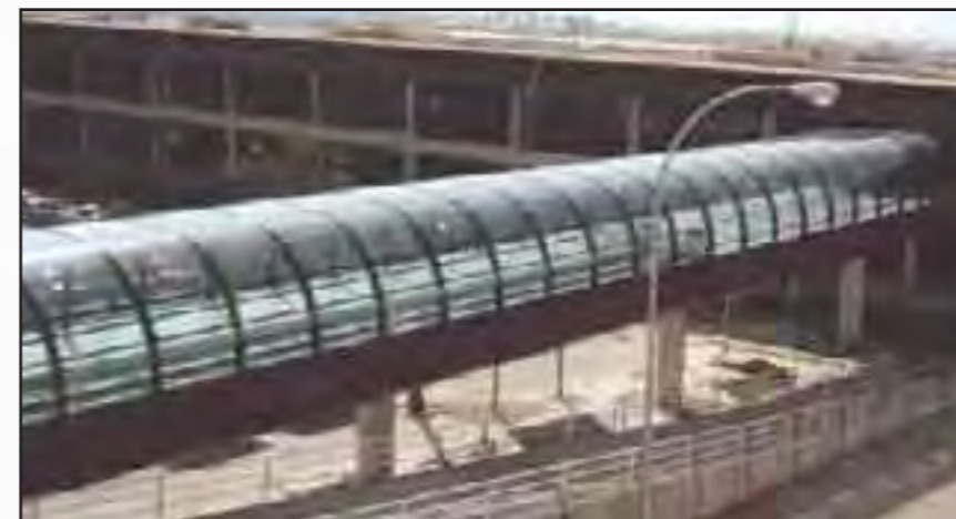
AEROPUERTO DE MALLORCA. Bóveda realizada con perfilería de aluminio y vidrio curvado. Todas las juntas verticales se revistieron con tapa y tapeta siendo las horizontales selladas con silicona neutra para permitir que el agua corra sobre la superficie sin obstáculos.
