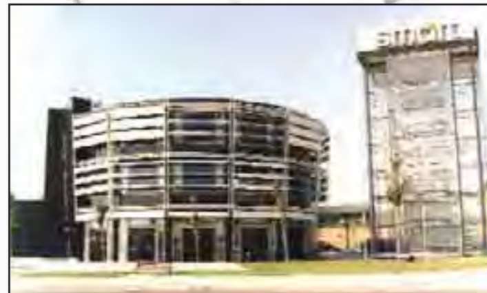
SEDE SMART - ALCOBENDAS - MADRID LEVACCI OBRAS Y CONSTRUCCIONES, S.A.
