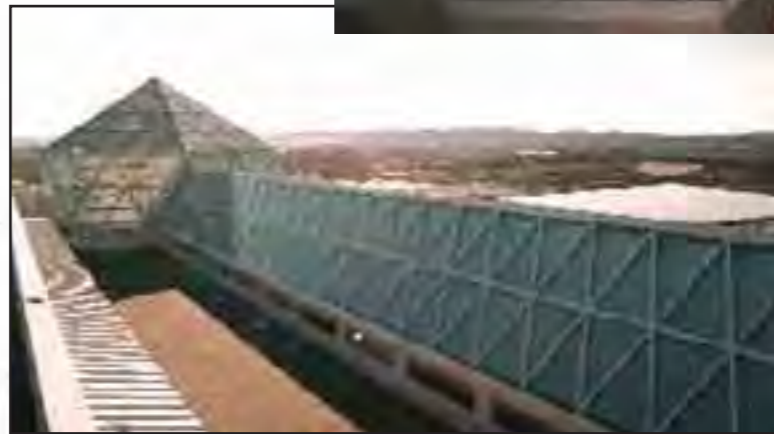
CENTRO COMERCIAL EL MIRADOR. CUENCA Lucernario en forma de icosaedro regular (20 lados) unido a otro de dos aguas, que aportan luz cenital al mall central del centro comercial.
