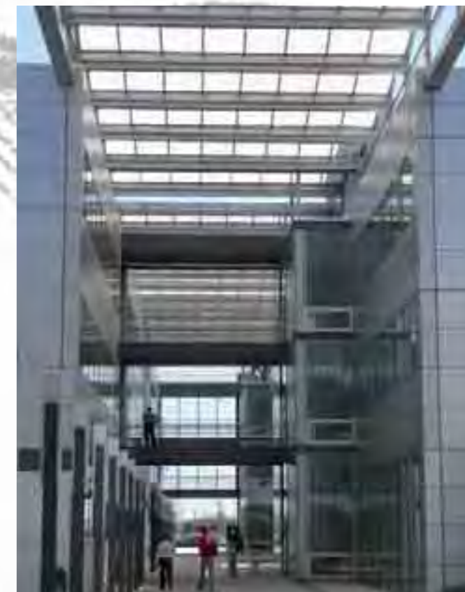
CENTRO DE SERVICIOS Y TECNOLOGIA SIEMENS - GETAFE - MADRID INGENIERIA: MACE ARQº: JULIO TOUZA Y ASOCIADOS, S.L.
