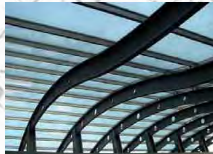
HOTEL URBAN - CARRERA DE SAN JERONIMO - MADRID CONSTRUCTORA SAN JOSE, S.A. ARQº.: D. CARLOS BASSO
