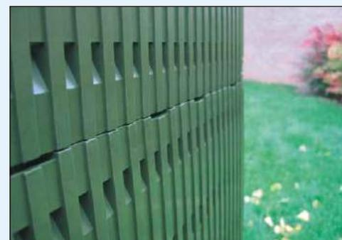
Sistema de aireación mediante agujeros en las paredes
