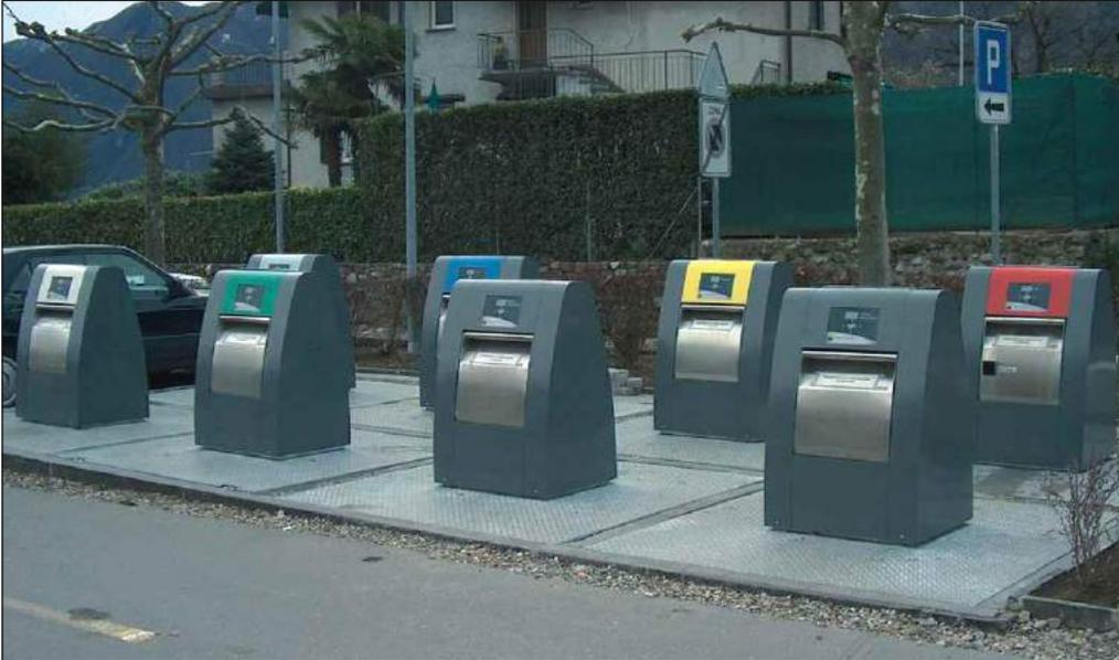
Sistema de contenedores soterrados con plataforma hidráulica
