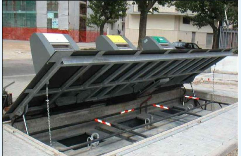
Detalle de apertura de la plataforma basculante para extracción/introducción de los contenedores
