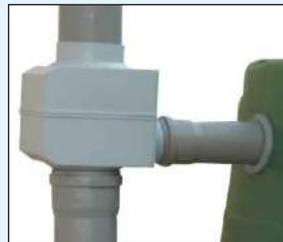
Detalle de instalación: canal, filtro y cuba
