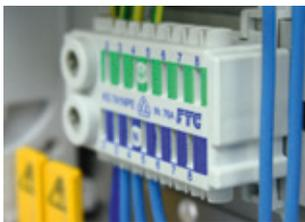
**Bloques de conexión rápida ECB**
