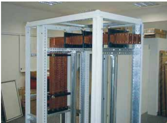
Embarrado en disposición vertical y horizontal en armario quadroplus.
