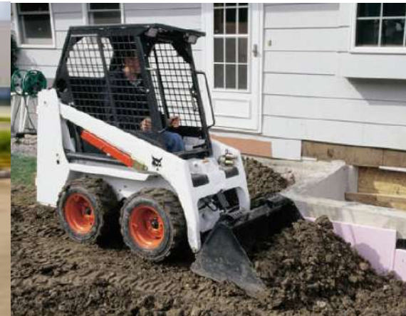
MOVIMIENTO DE TIERRA
