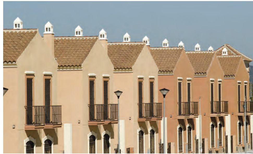
ordesa teja cerámica mixta de: 466 x 275 mm. / coloración en masa: rojo / peso: 3800 gr. / 11,3 piezas por m 2
