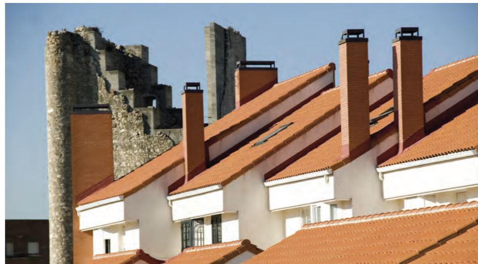
roja teja cerámica mixta de: 466 x 275 mm. / coloración en masa: rojo / peso: 3800 gr. / 11,3 piezas por m 2
