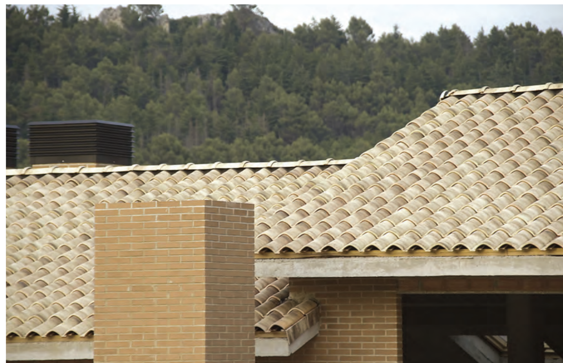
Casares teja cerámica mixta de: 466 x 275 mm. / coloración en masa: rojo / peso: 3800 gr. / 11,3 piezas por m 2
