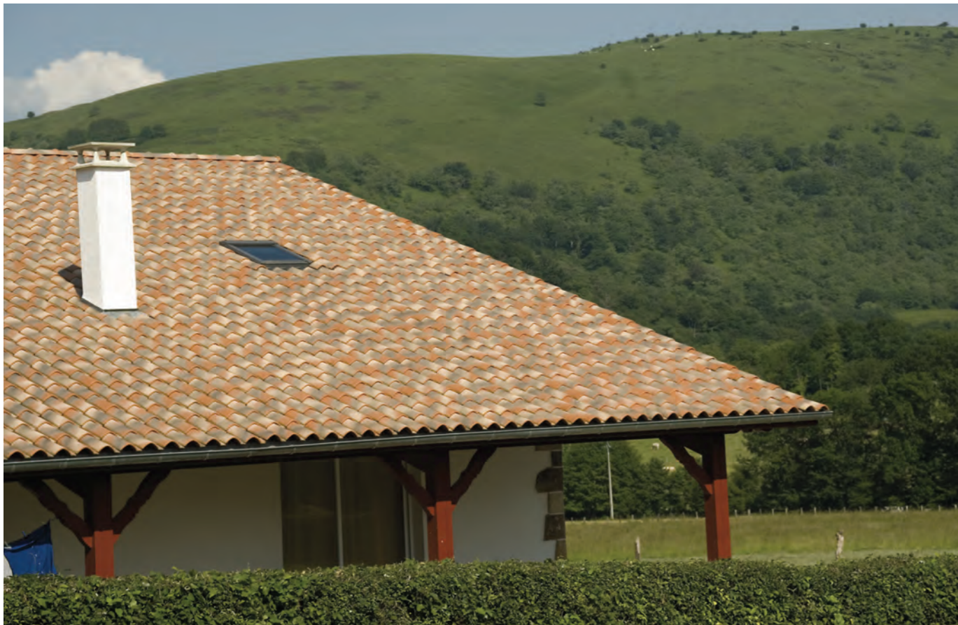
provenzal teja cerámica mixta de: 466 x 275 mm. / coloración en masa: rojo / peso: 3800 gr. / 11,3 piezas por m 2
