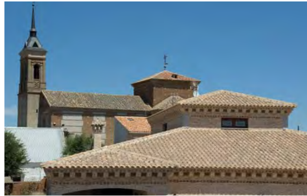
crema flameada teja cerámica occitania de: 466 x 273 mm. / coloración en masa: rojo / peso: 3840 gr. / 12,2 piezas por m 2
