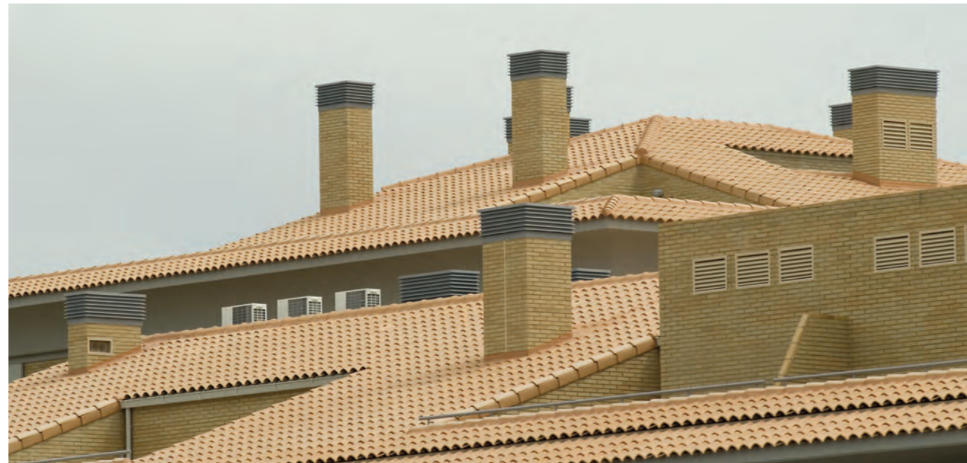
duna teja cerámica mixta de: 472 x 282 mm. / coloración en masa: salmón / peso: 3625 gr. / 11,3 piezas por m 2
