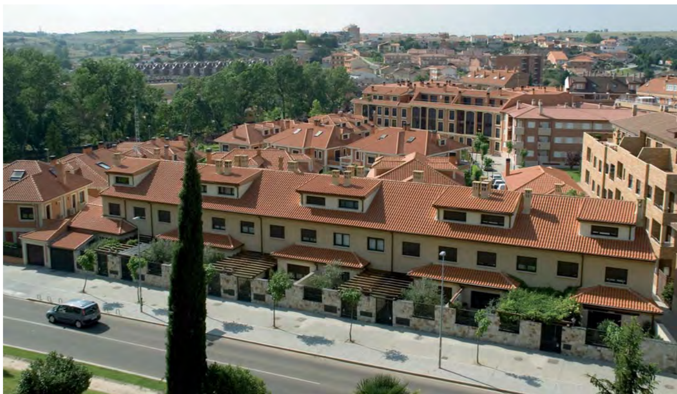
roja teja cerámica occitania de: 466 x 273 mm. / coloración en masa: rojo / peso: 3840 gr. / 12,2 piezas por m 2
