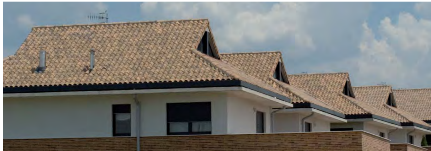
crema envejecida teja cerámica occitania de: 466 x 273 mm. / coloración en masa: rojo / peso: 3840 gr. / 12,2 piezas por m 2
